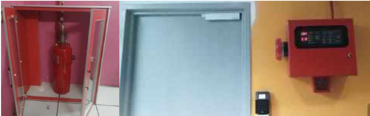
Sistem Pencegahan Kebakaran Di Bilik Server Bahagian Sistem Maklumat
