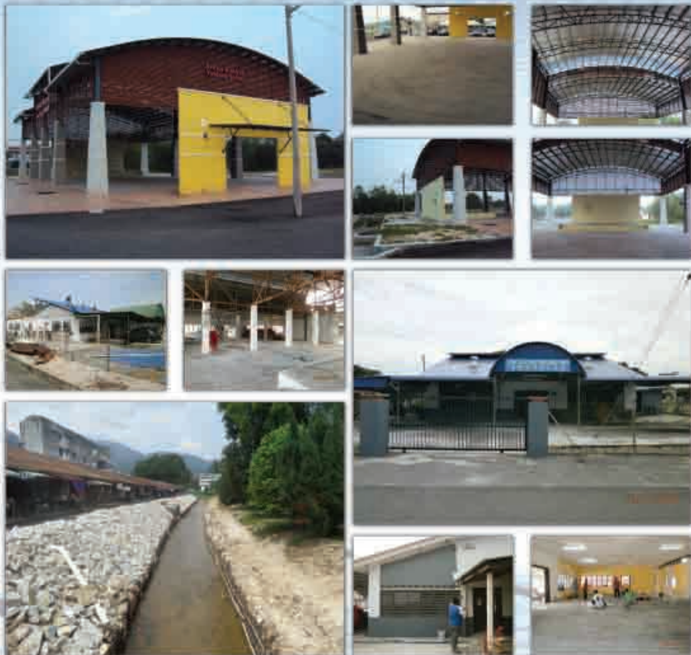
Arena Rakyat Tualang Sekah / Dewan Orang Ramai Tronoh Mines / Tebing Jalan Baru
